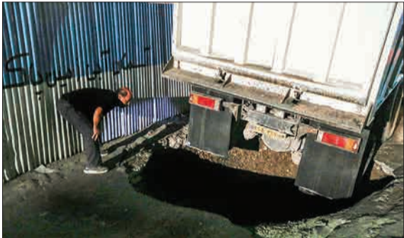
بر اثر نشست زمین در خیابان آزادی تقاطع استاد معین چرخ های یک دستگاه کامیون در چاله فرو رفت که با تلاش نیروهای آتش نشانی و امدادی کامیون از محل نشست زمین خارج شد.
