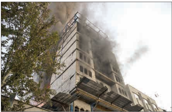
عصر روز گذشته ساختمانی در حال ساخت حوالی خیابان شهید قرنی، خیابان کلاکتری طعمه حریق شد. با حضور به موقع آتش‌نشانان این حادثه خوشبختانه خسارت جانی در برداشته است. مهر
