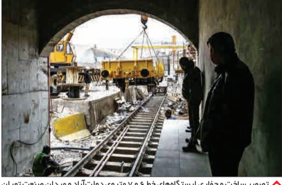
تصویر ساخت و حفاری ایستگاه های خط ۶ و ۷ متروی دولت آباد و میدان صنعت تهران را نشان می دهد. بخش عمده ای از این خط به روش مکانیزه احداث شده است و به دلیل رعایت اصول مهندسی و استانداردهای فنی در ساخت به فینال ابر پروژه های تونل سازی اجرا شده است. (ایرنا)
