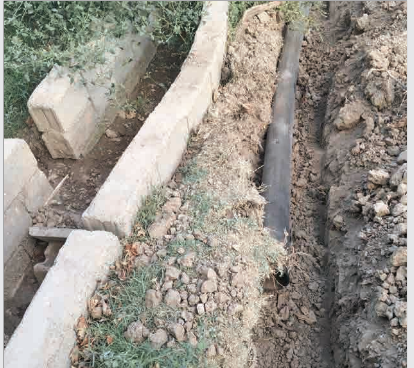
لوله آبی که دقیقاً به موازات جوی آب قدیمی محله جاسازی شده است
