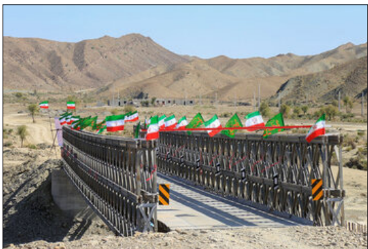
ایرنا- بندرعباس - پل جگین بشاگرد با حضور محمد اسلامی وزیر راه و شهرسازی و استاندار هرمزگان با هدف تسهیل ارتباط مواصلاتی ۴۸ روستا به بهره‌برداری رسید.
